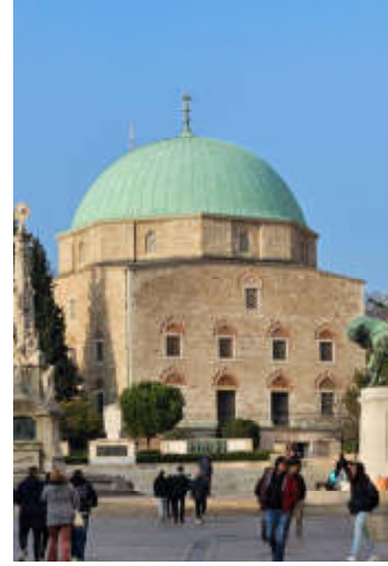
Peçuy'da Gâzî Kâsım Paşa Câmii (2024)
